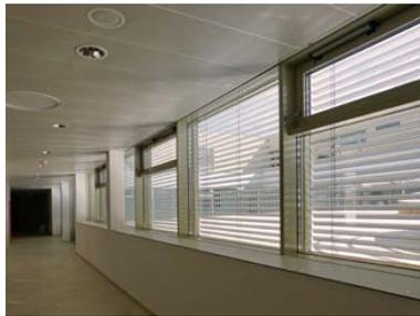
Blendfreie Aussicht in den gleißend hellen Schulhof. Das von den Raffstore-Lamellen gelenkte Tageslicht erhellt den Gang ohne Wärmeeintrag durch direkte Sonneneinstrahlung. (Bild: Schlotterer)
