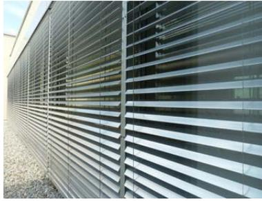
Außenraffstoren zählen zu den effektivsten und energiesparendsten Methoden, sommerliche Überwärmung zu vermeiden. Das Prinzip ist einfach: der Raffstore lässt die direkten Sonnenstrahlen in der heißen Jahreszeit erst gar nicht bis an die Fensterscheiben heran. (Bild: Schlotterer)
