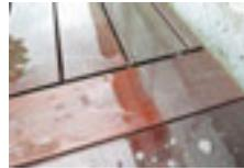
Die Dielen werden mit der Reinigungsflüssigkeit eingesprüht und nach ca. 10 Minuten Einwirkungszeit abge mit dem Schlauch oder einem Hochdruckreiniger abgespritzt.
