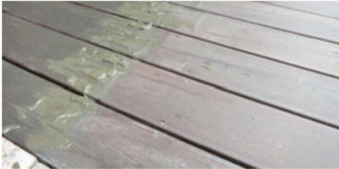
Im Zuge der Wartung ist die Terrasse mindestens einmal jährlich auf Veränderungen und Schäden zu kontrollieren. Besonderer Wert ist dabei auf die Beseitigung nutzungsbedingt entstandener Feuchtenester (z.B. Verschmutzungen im Bereich der Kreuzungspunkte Belag/Unterkonstruktion) zu legen. Nach Möglichkeit sollte auch der wasserführende Untergrund unter einem flächig aufliegenden Lattenrost gereinigt werden.
