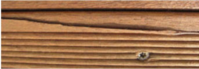
Wie bei der Konstruktion ist es auch in der Nutzung wichtig, die Entstehung von Feuchtenestern zu vermeiden. Eine Unterlüftung ermöglichen Leisten, Abstandshalter oder Untersetzer, die nur punktuellen Kontakt zur Terrasse aufweisen. Blumentöpfe und Pflanztröge sollten grundsätzlich nicht vollflächig am Untergrund aufliegen!
