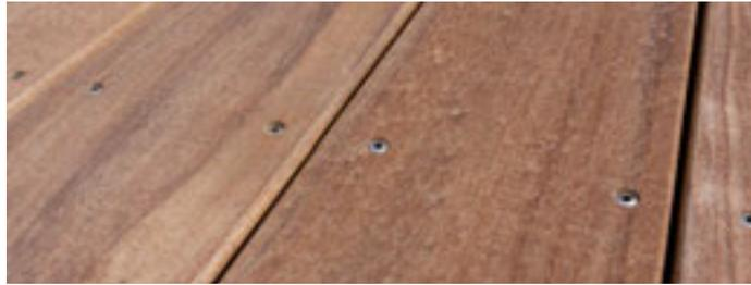
Die sichtbare Befestigung von Holz-Terrassendielen erfolgt über die klassische Verschraubung der Dielen mit rostfreien Edelstahlschrauben – technisch gesehen die beste Form der Befestigung. Die Terrassendielen werden vorgebohrt und die Bohrlöcher ausgerieben. So können die Schraubenköpfe oberflächenbündig in die Diele versenkt werden. Die Schraubenlänge sollte das 2,5-fache der Dielendicke ausmachen.
