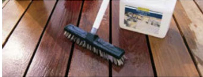
Bei Flächen ab ca. 50 m<sup>2</sup> lohnt sich der Einsatz eines geeigneten Reinigungsgerätes. Sie benötigen für die Reinigung nur Wasser und – je nach Verschmutzungsgrad – den WOCA Terrassenreiniger oder den FANO WPC Intensivreiniger.
